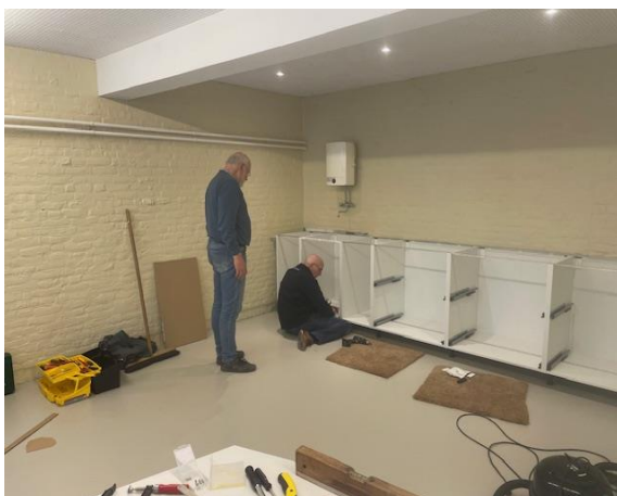
Installatie van de keuken
